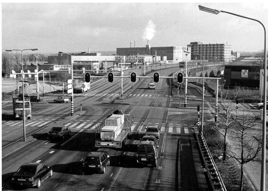
Foto 2 Kruispunt Via- ductweg/Noor- derbrug/ W.Alexanderweg: Reductie ver- keersongevallen door verhoging verlichtings- niveau van de openbare verlichting en verkeersregel- installatie
