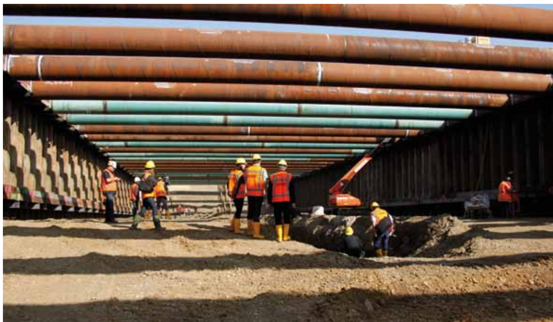
Grote werken: Ondertunneling van de A2
